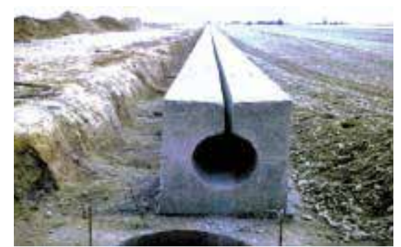
Longitudinal «Satujo» type slot gutter
